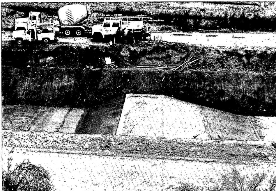
Figura 3.22 Vertedero de gran tamaño, en el Canal Arizona, durante su construcción.
