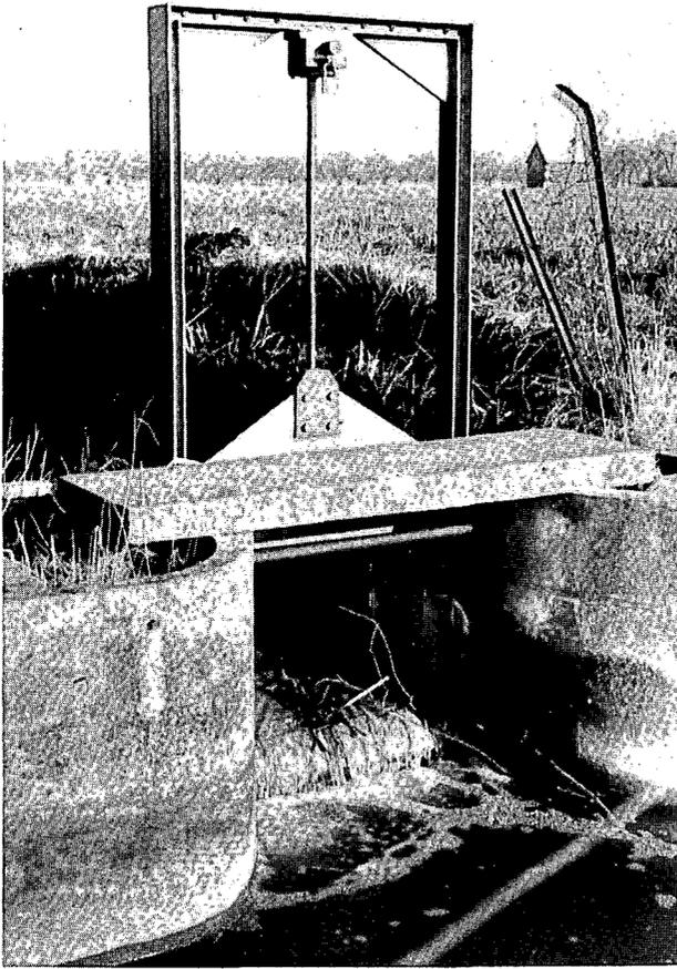
Figura 1.20 Las ramas largas pueden quedar retenidas y deben ser retiradas de la coronación del vertedero. (Por cortesía del Laboratorio de Hidráulica de Delft, Países Bajos.)
