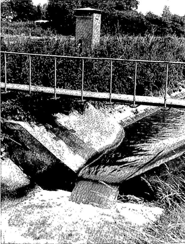
Figura 7.20 Si no se necesita recuperar energía cinética, es adecuado disponer una expansión súbita en la salida (Países Bajos).
