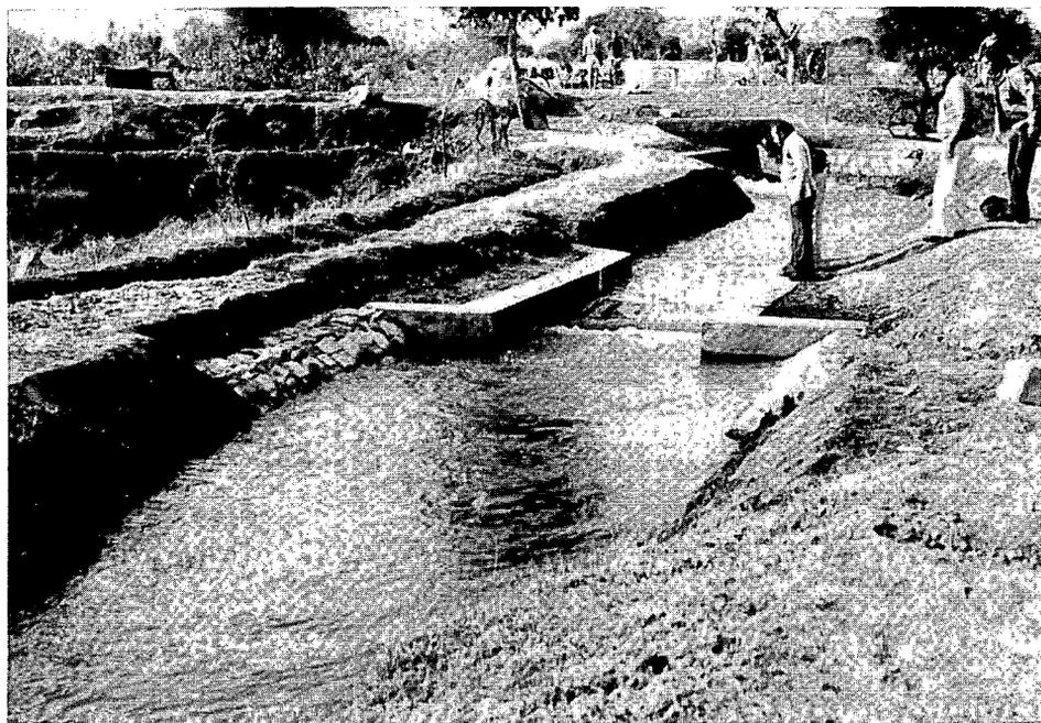
Figura 4.2 Obra de medición con sección de control rectangular en un canal de tierra (India).
