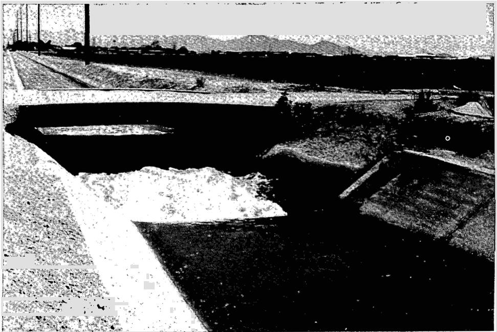
Figura 1.21 Un salto en un canal puede ser fácilmente convertido en un punto de medición (Arizona).
