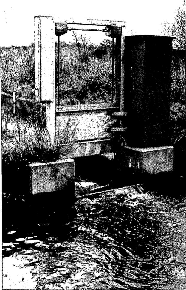
Figura 6.9 Vertedero móvil con garita para el registrador automático (Por cortesía del Laboratorio de Hidráulica de Delft, Países Bajos).
