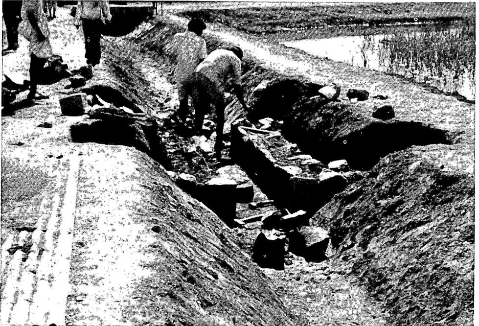
Figura 4.5 Construcción de una obra de medición rectangular, en un canal de tierra, con piedras y mortero (India).
