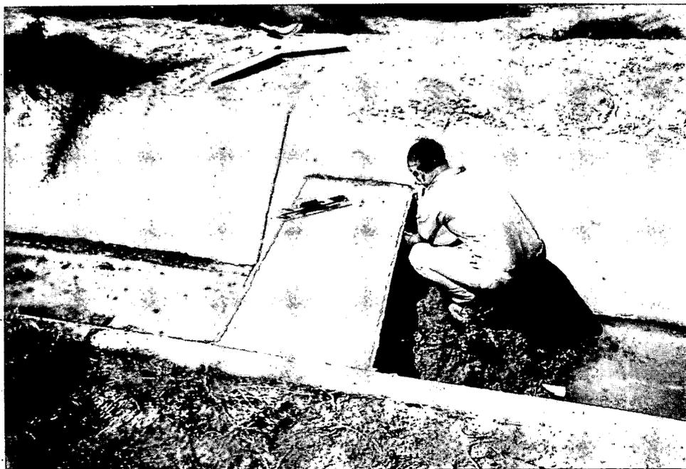
Figura 3.12 Una vez que el resalto de hormigón ha fraguado, se retira el encofrado de aguas arriba.
