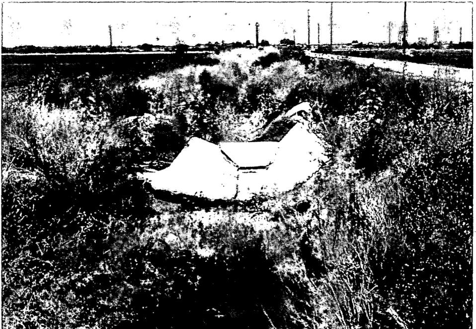
Figura 4.10 Si el relleno no está bien compactado y se olvidan los muros de pie, la obra fallará (Arizona).
