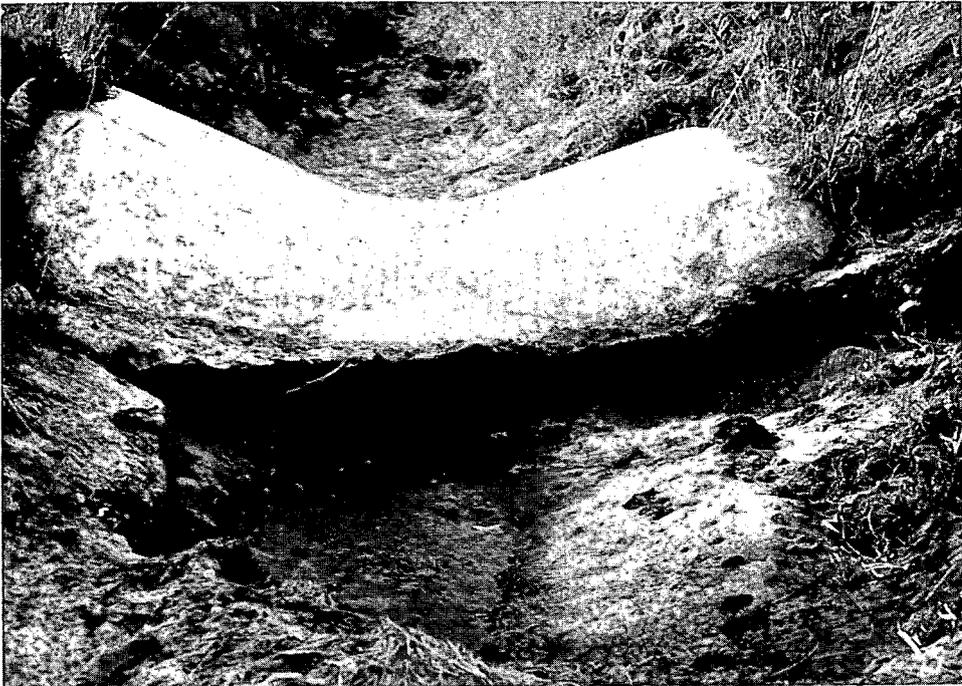
Figura 8.15 Para evitar su deterioro, a este aforador se le debe añadir un muro de pantalla y un empedrado protector.
