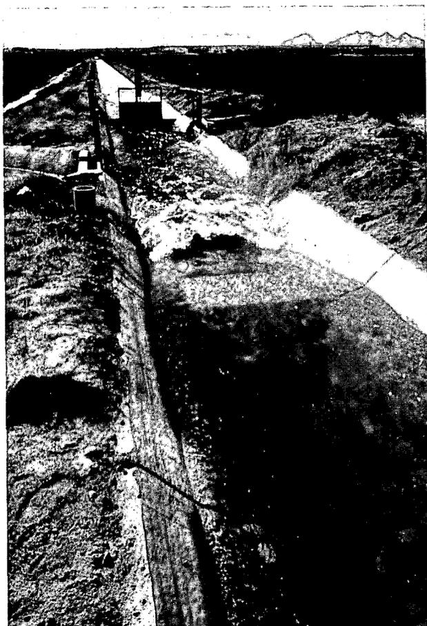
Figura 1.4 Vertedero de madera de uso temporal en un canal de riego (Arizona).
