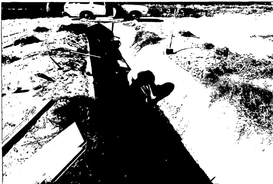
Figura 3.8 La zanja se limpia de residuos antes de colocar el encofrado (Arizona).
